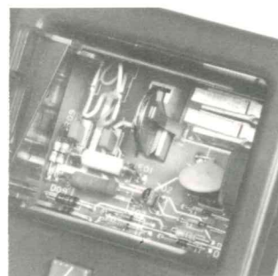
Emplacement de la pile et strappages
